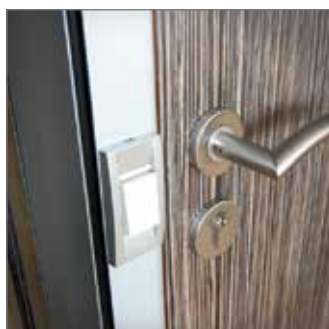
Interrupteur intégré au montant d' huisserie Light switch integrated to the door jamb
